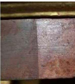
Als erstes entfernten wir die lose Staubablagerung und die schon mit dem Untergrund fest verbundene Schmutzschicht. Dabei musste sehr vorsichtig vorgegangen werden und vorab musste z.T. lose Fassung gefestigt werden, damit sie nicht verloren geht.
